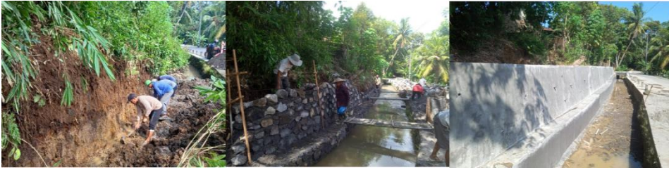
Gambar 4.3. Perbaikan Jaringan Irigasi
