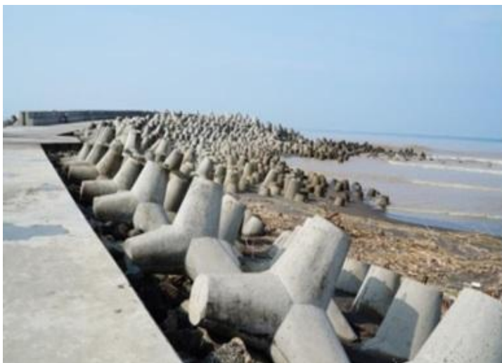
Gambar 6.3. Breakwater Pelabuhan Perikanan Tanjung Adikarta
